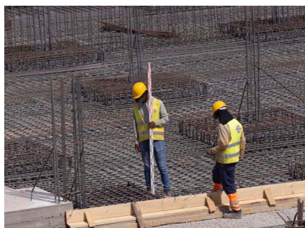
Station de pompage SP1 · Safi
